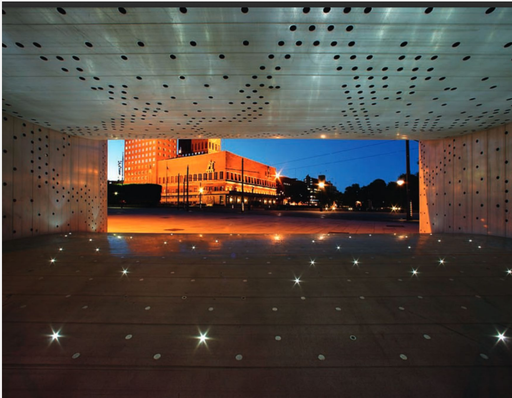
Stavba – klenba vyhotovená FSW metódou
