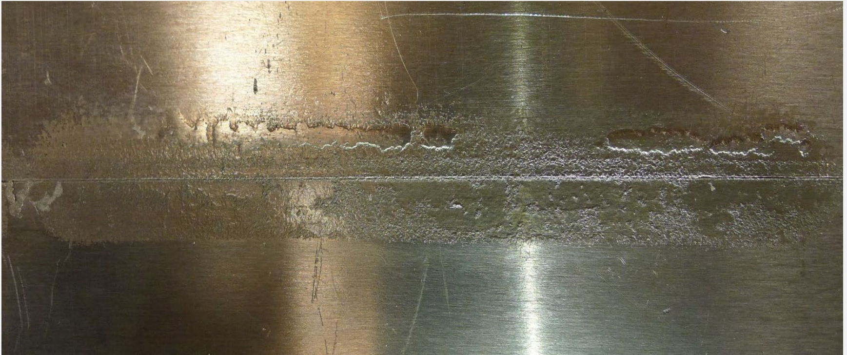
Formare incorectă a rădăcinii îmbinării
