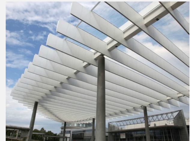
Pasarela si scut pentru intemperii
