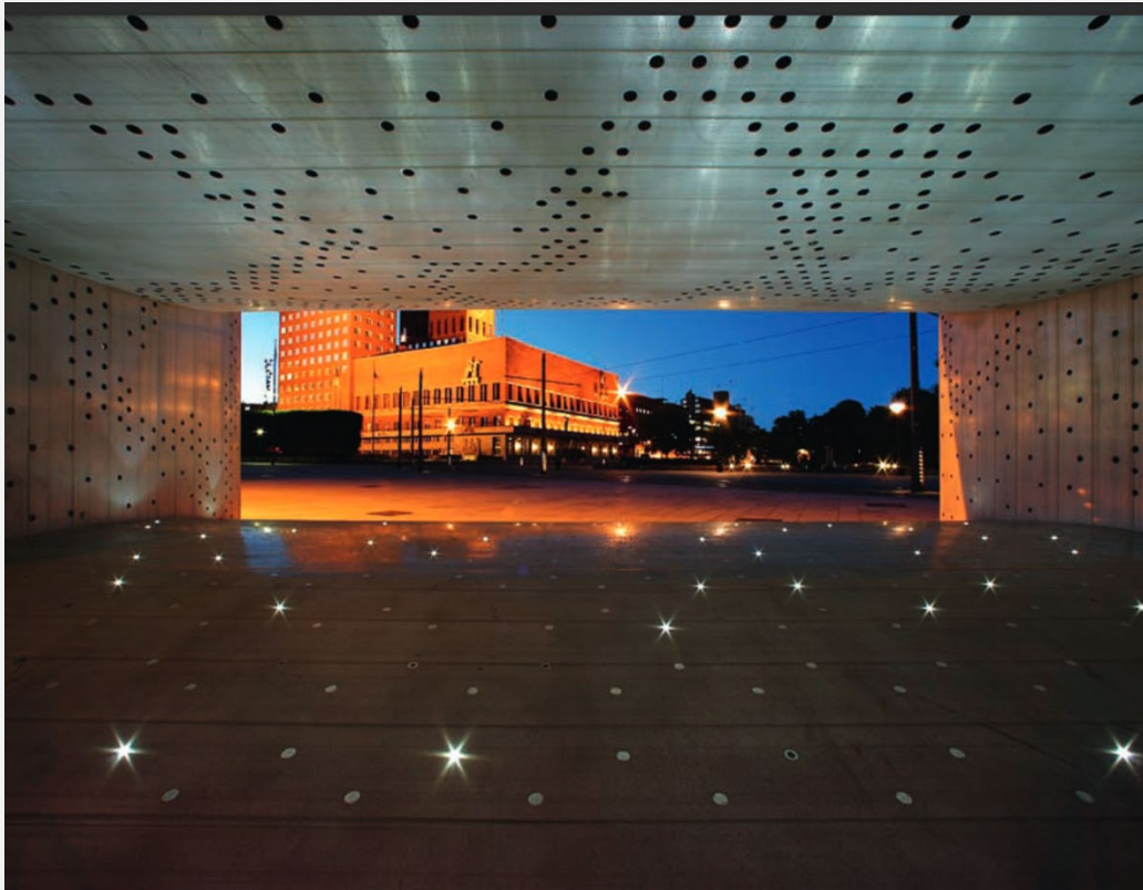
Constructii – bolta realizata cu FSW
