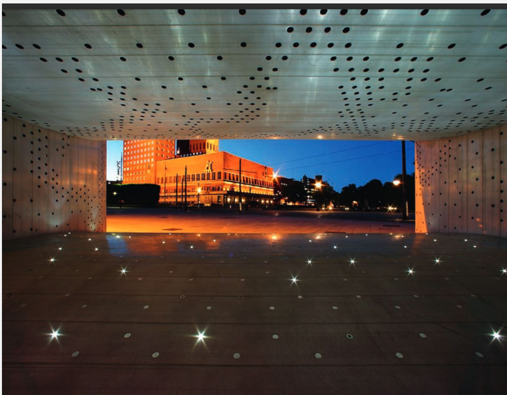
Výstavba – klenba vyhotovená FSW metódou
