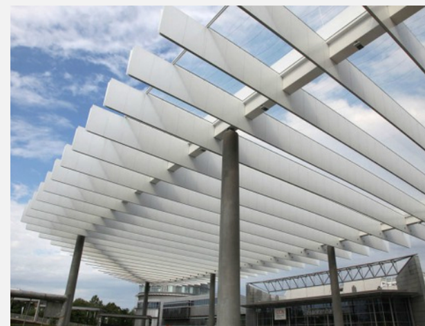
Pasarela si scut pentru intemperii
