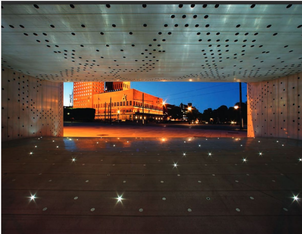
Constructii – bolta realizata cu FSW
