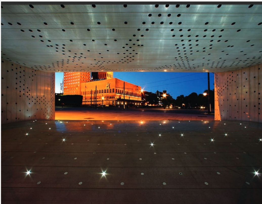
Construção – cobertura fabricada por SFL
