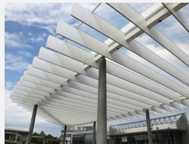
Corredor/passagem e proteção contra o tempo
